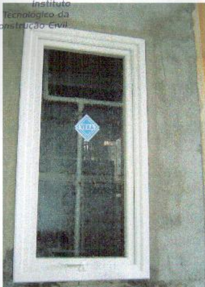
Foto nº. 03 Verificação da estanqueidade à água.
