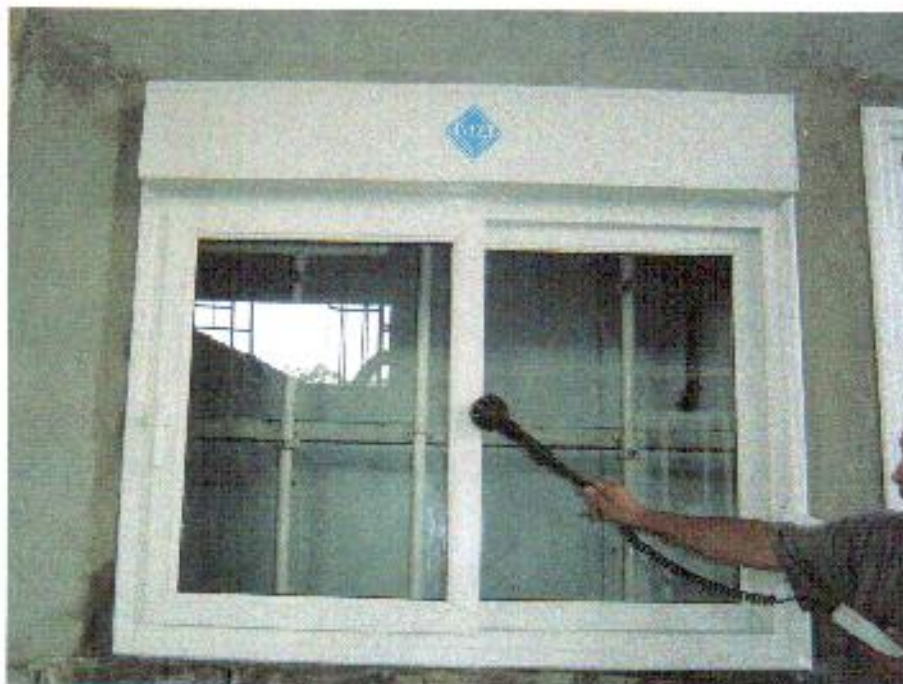
Foto nº. 03 Verificação da penetração de ar.
